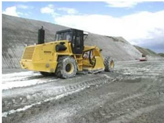
Figura 2.- Estabilización de suelos
